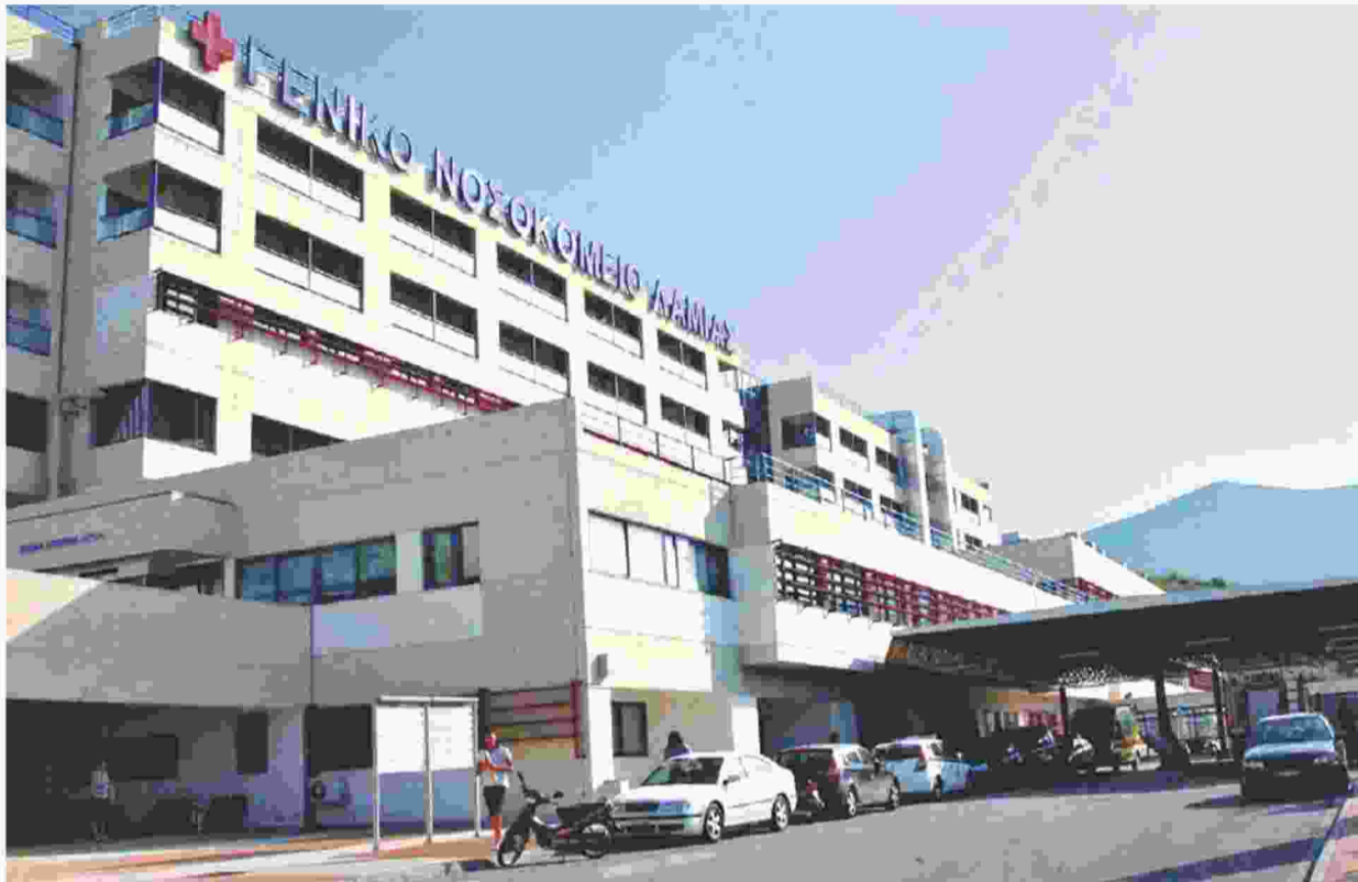
Η ΥΠΟΣΤΕΛΕΧΩΣΗ του αναισθησιολογικού τμήματος του Νοσοκομείου Λαμίας καθιστά αδύνατη τη λειτουργία του χειρουργείου
