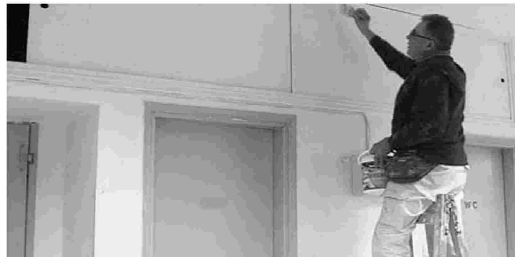
Στο κτίριο που στεγάζεται σήμερα το ΠΕΔΥ στη Νέα Ιωνία, και θα λειτουργήσει ως TOMY, βρίσκονται σε πλήρη εξέλιξη εργασίες ενόψει των εγκαινίων
