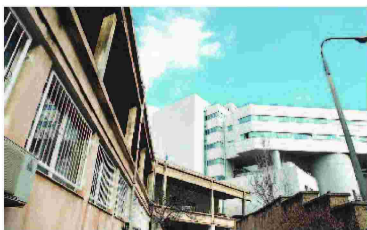
Το επίμαχο κτίριο στην... οκιά του «Ερρίκος Ντυνάν»
