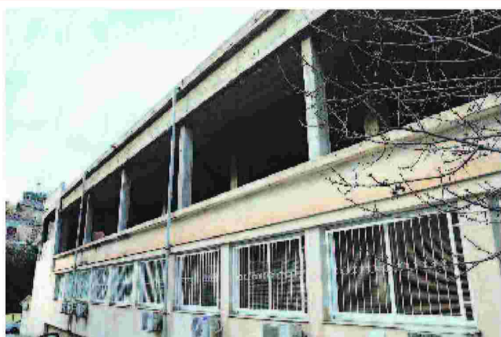
Από τα 8.840 τ.μ. του επίμαχου «συνδεδειγμένου κτιρίου» ένα μέρος έμεινε (τυχαία;) γιατί
