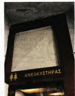
Ο ανεκυστήρας του κτηρίου λειτουργεί χωρίς άδεια
