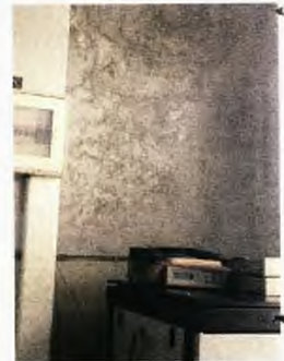
Η μούπλα και η υγρασία «βασίλειουν» στο δωμάτιο του server
