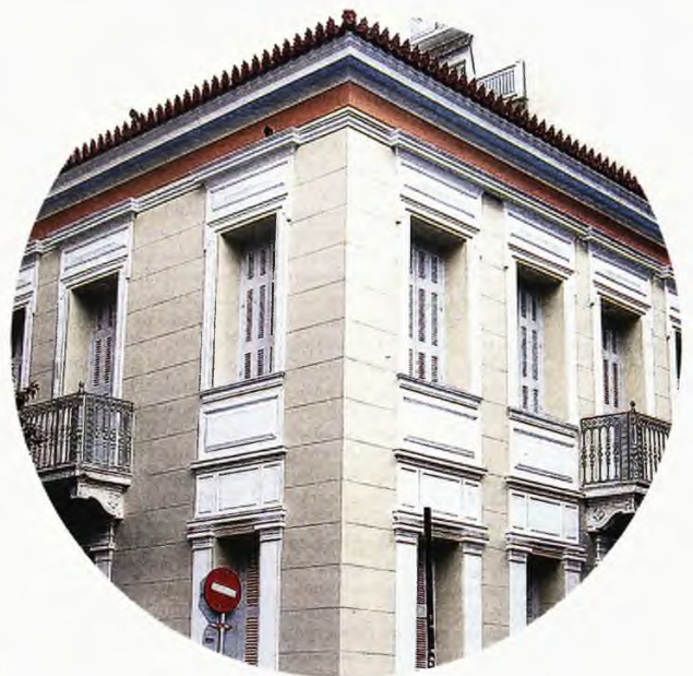
Το ανακαινισμένο κτίριο του Φαρμακευτικού Συλλόγου Πειραιά
