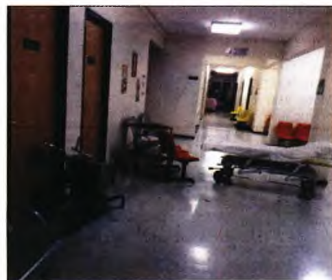
Οι ζημιές που προκάλεσε στον θάλαμο αναμονής ο δράστης
