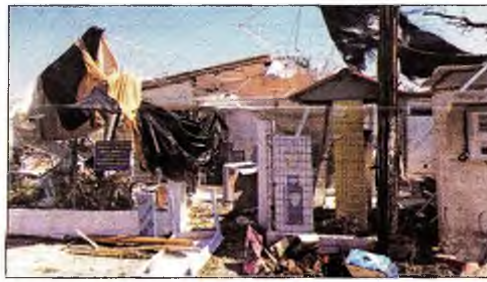
Κατεστραμμένο σπίτι στον οικισμό Δελφίνια στη Σωζόπολη
