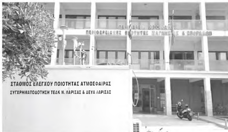
ΣΤΑΘΜΟΣ ΕΛΕΓΧΟΥ ΠΟΙΟΤΗΤΑΣ ΑΤΜΟΣΦΑΙΡΑΣ ΣΥΓΧΡΗΜΑΤΟΔΟΤΗΣΗ ΤΕΑΚ Ν. ΛΑΡΙΣΑΣ & ΔΕΥΑ ΛΑΡΙΣΑΣ
