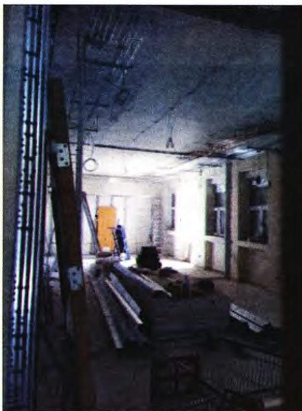
Υπό κατασκευή ΜΕΘ στο Νοσοκομείο «Σωτηρία»
