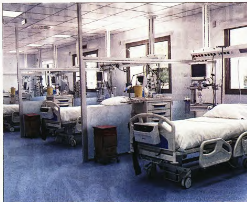
Εξοπλισμός των νέων κλινών ΜΕΘ που εγκαταστάθηκαν στο Νοσοκομείο «Σωτηρία»
