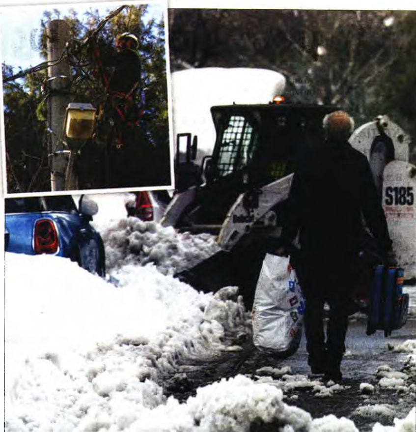
Συνεχίζεται ο γολγοθάς των κατοίκων των βορείων προαστίων που έχουν μείνει για ημέρες χωρίς ρεύμα. Ενθετή: Από τις εργασίες των συνεργείων για την αποκατάσταση της ηλεκτροδότησης
