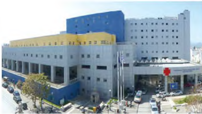
Εξαιτίας της ασφυκτικής πίεσης, που δέχεται πλέον το Νοσοκομείο Βόλου λόγω αύξησης νοσηλείων, άνοιξε τρίτη κλινική, όπως είχε γίνει αντίστοιχα τον περασμένο Νοέμβριο
