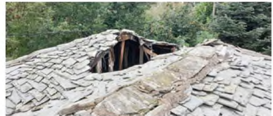
Η μία από τις τρύπες, που «χάσει» στη σκεπή του κτιρίου του Κέντρου Υγείας Ζαγοράς
